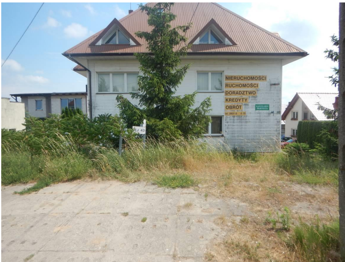
Fot. 7 Budynek mieszkalny – receptor nr 159 dla wariantu W1 i W2
