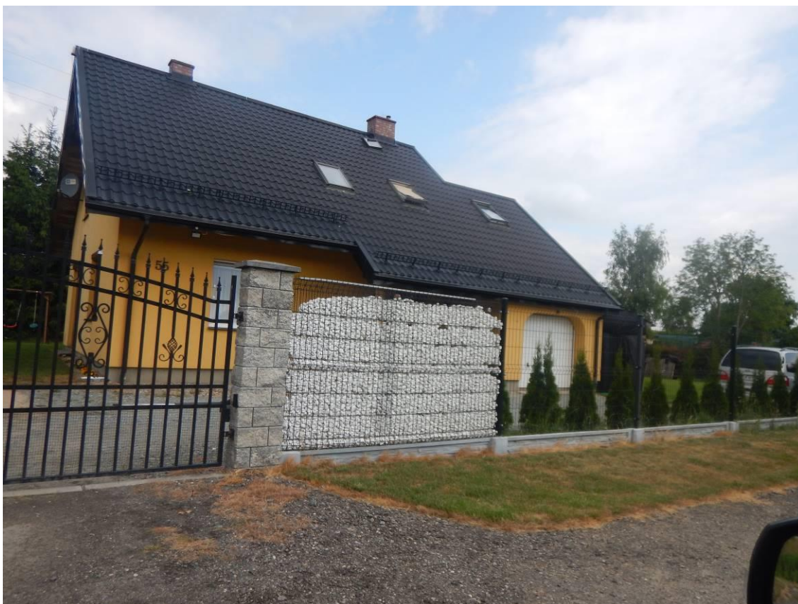
Fot. 15 Budynek mieszkalny – receptor nr 181 dla wariantu W1 i W2
