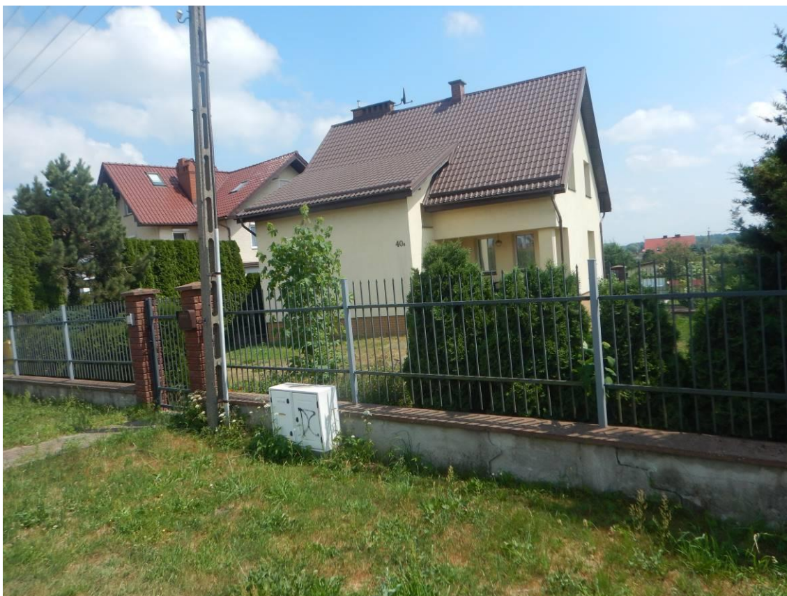
Fot. 5 Budynek mieszkalny – receptor nr 157 dla wariantu W1 i W2
