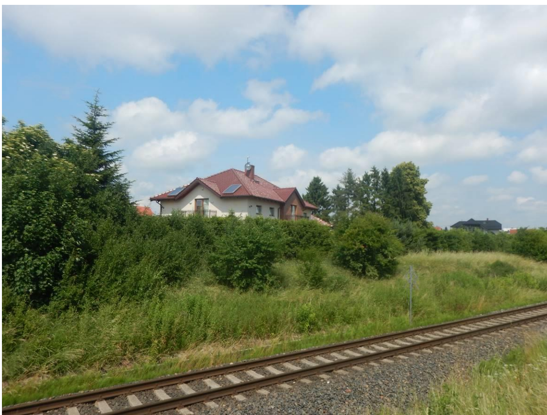
Fot. 4 Budynek mieszkalny – receptor nr 152 dla wariantu W1 i W2
