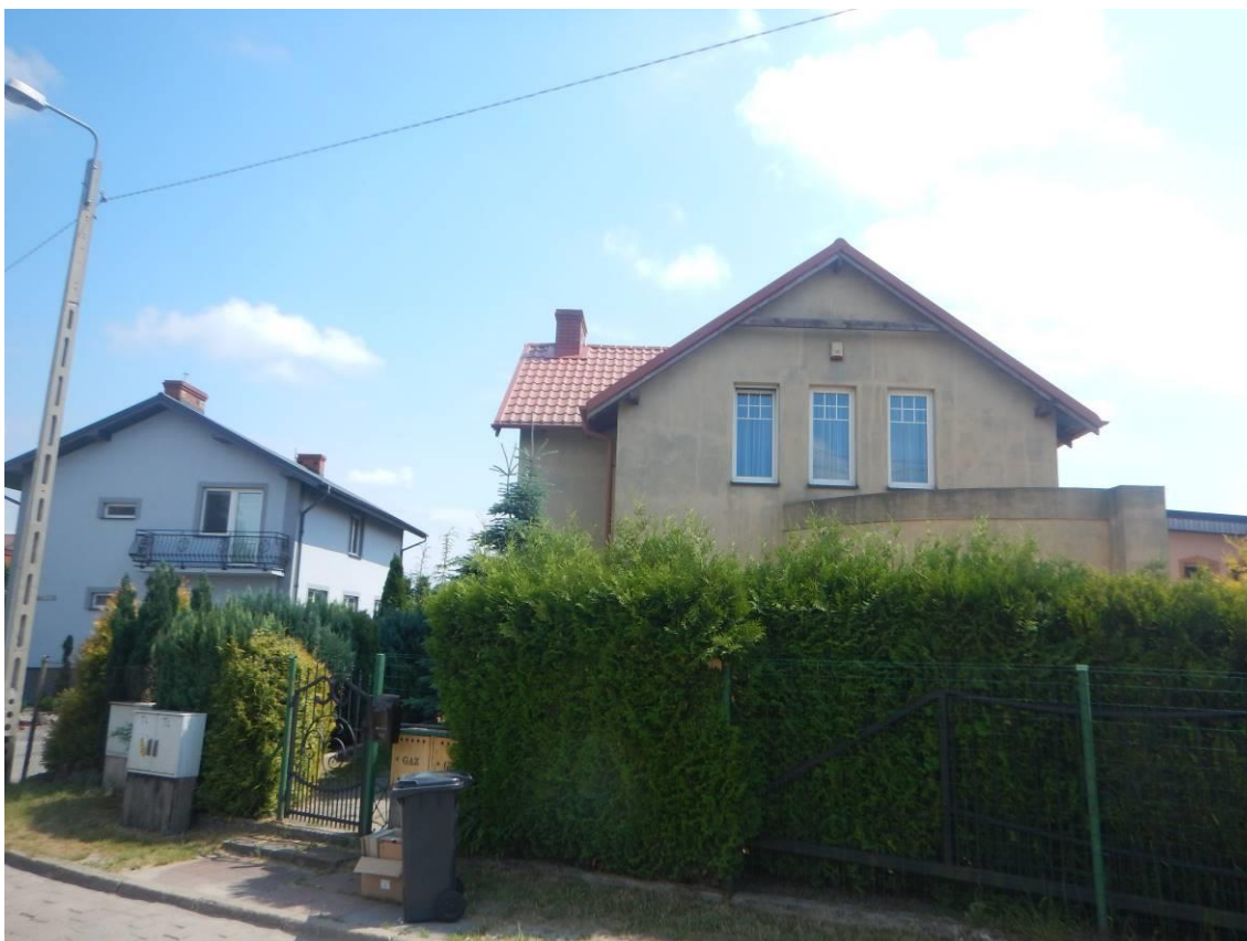
Fot. 2 Budynek mieszkalny – receptor nr 149 dla wariantu W1 i W2
